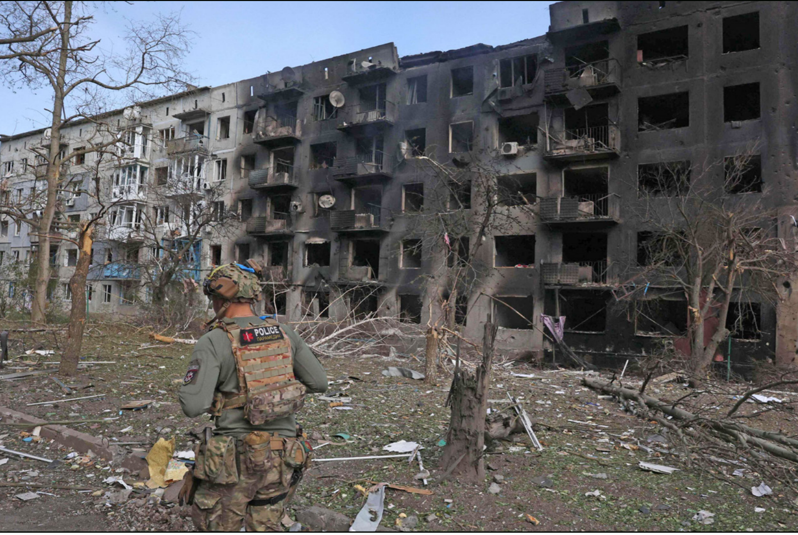
شرطي أوكراني يمر أمام مبنى مدمر في أفدييفكا
